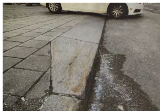
Figure 11 : Photo de l'entrée charretière recommandée
